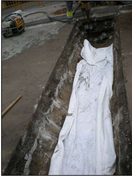
Foto 25: Cobriment amb geotèxtil del tram de la Muralla de Mar del segle XIX.
